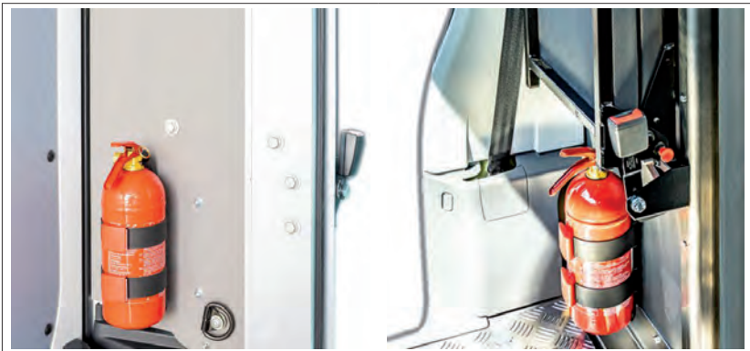
Figura 3: Estintori sulla posta scorrevole del vano di carico (sinistra), nella cabina di guida (destra)
