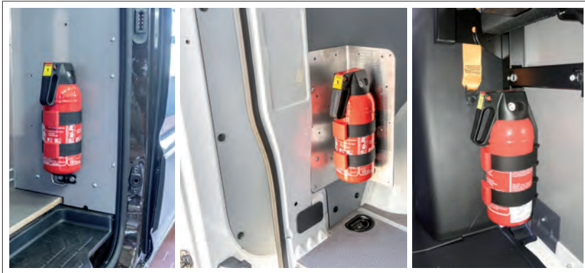
Figura 3: Extintor de incendios junto a la puerta corredera del área de carga y en la cabina del conductor (derecha)
